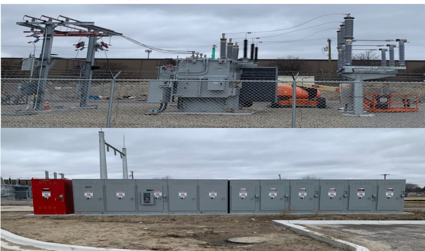
圖六：已與 DTE Energy 合作安裝專用於該工廠的 15MW 變電站
